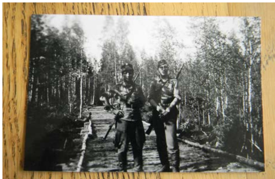
Eskil tillsammans med Henry Haga från Närpes på en kabelbro. Sådana byggdes i skogen för att underlätta transporter med häst eftersom det var för farligt att använda vägarna.
