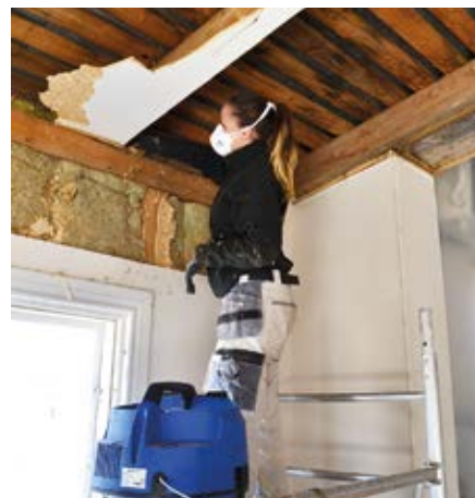
Sara plockar ned isoleringen.
